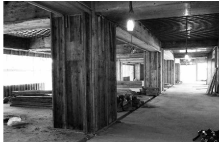
型枠を解体中の様子
