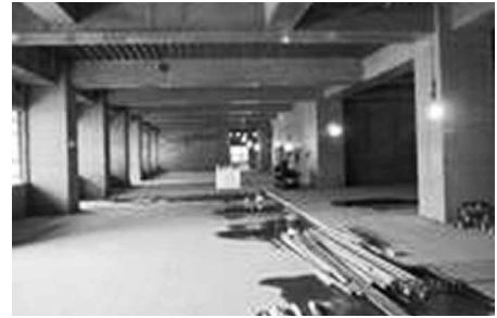
型枠を解体後の様子
